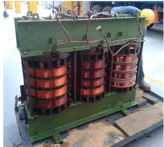
Figure 1 transformador de 1500kVA desensamblado.
